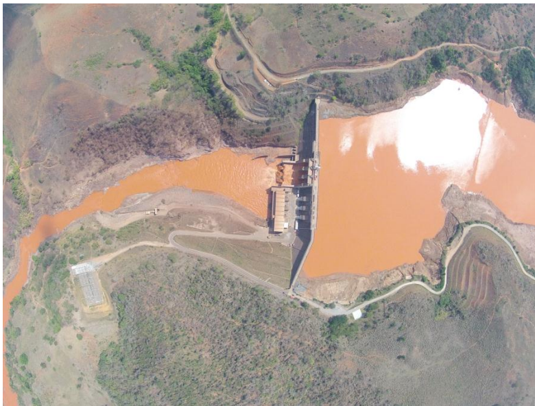
Figura 11 - Rio Doce na altura da Barragem de Candonga, Rio Doce-MG
